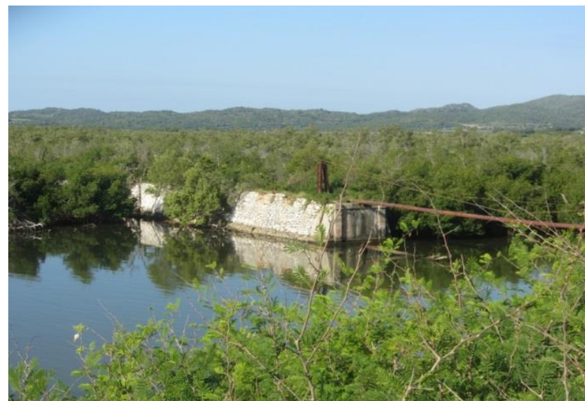
Trinkwasserleitung aus den 1950ern
