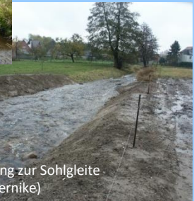
Wehranlage vor der Umgestaltung (Foto: N. Wernike)
